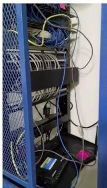
**Figura 5.** Rack con switch de 16 puertos
