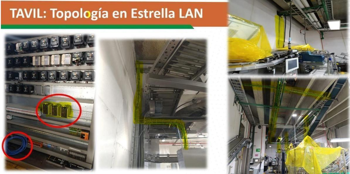
**Figura 6.** Tipología utilizada en la infraestructura (estrella)
